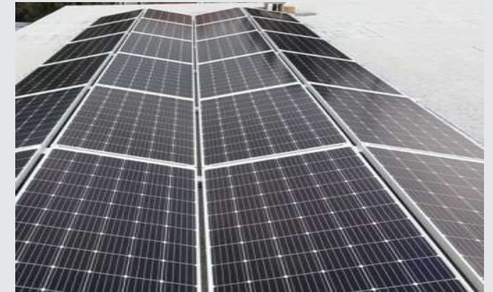
Pose en double shed
